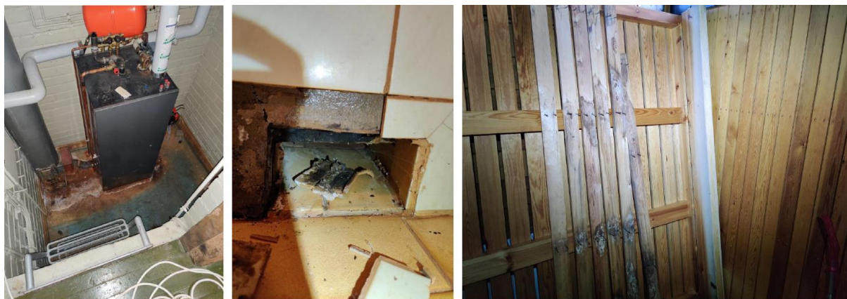
Kuva 23. Työmaakuvia edustussaunan kuntoselvityksen työmaakäynniltä 22122021 (kuva: Teppo Siponkoski, FCG 2021)
